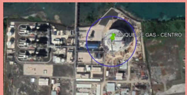
Center of LNG tank
