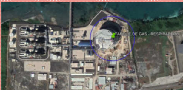
Right end of LNG tank
