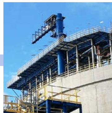
Crane in LNG tank
